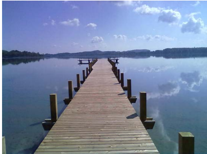
Erholungsgebiet Oberndorf erneuerter Badesteg
