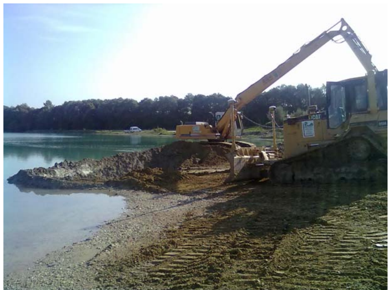
Baustelle Pullinger Seen 2. Bauabschnitt
