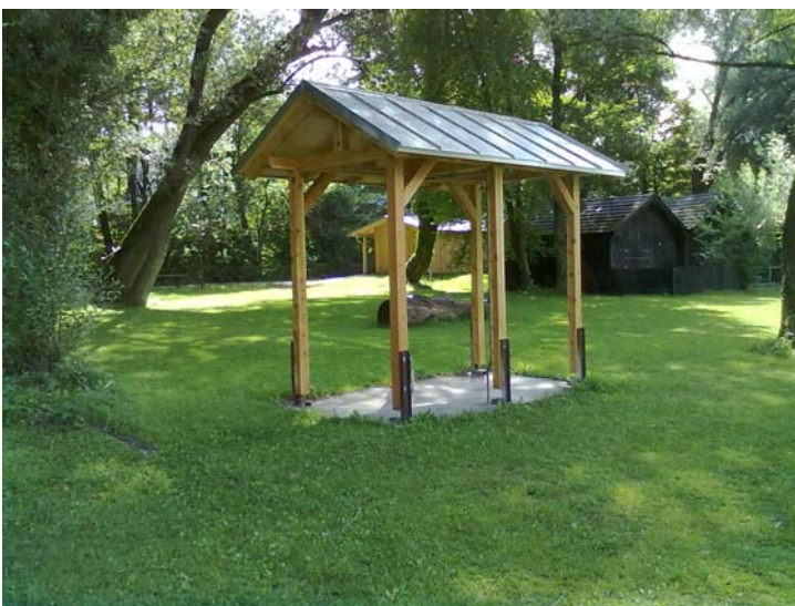
Stegen a. A. Duschplatz und Sanitärgebäude im Hintergrund
